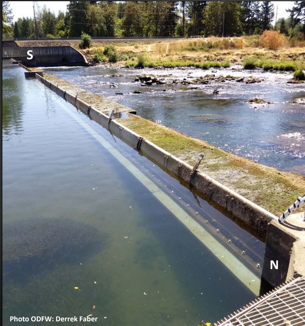
Spanning antenna LD4
